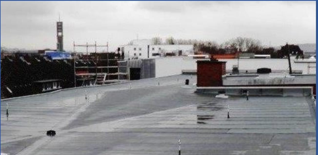
Durch starke Regenfälle werden Kehlen Jahr für Jahr mehr belastet. Dies kann dazu führen, dass sie absacken und die Statik des Gebäudes belasten.
