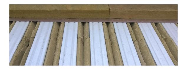
Sickenfüller werden hauptsächlich aus nicht brennbarer Mineralwolle gefertigt, auf Wunsch aber auch aus anderen Dämmstoffen.
